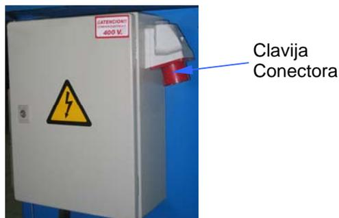
Fig. 3-1 Clavija Conectora
